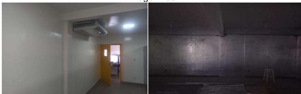
Figura 08 - Reforma para isolamento térmico de sala do herbário no Campus II – Alagoas
