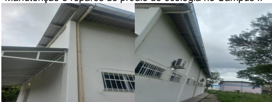
Figura 07 - Manutenção e reparos do prédio de ecologia no Campus II – Alagoas
