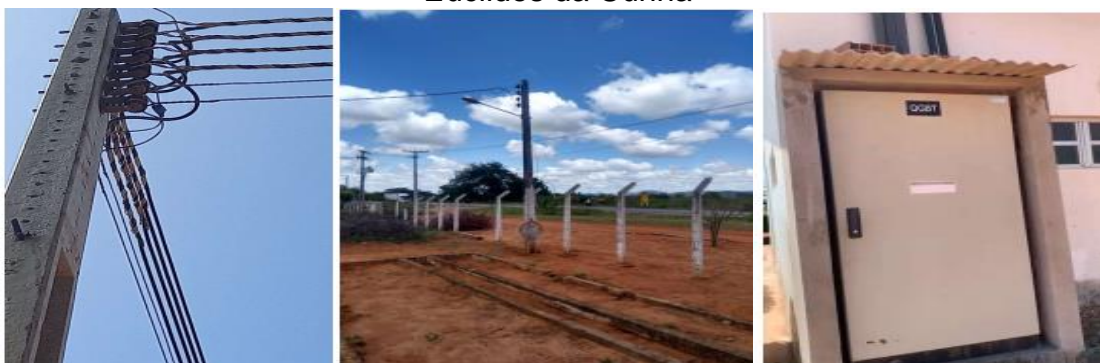
Figura 20 - Reforma elétrica no Pavilhão Laboratórios e Iluminação Externa do Departamento de Ciências Humanas e Tecnologias (DCHT) no Campus XXII - Euclides da Cunha
