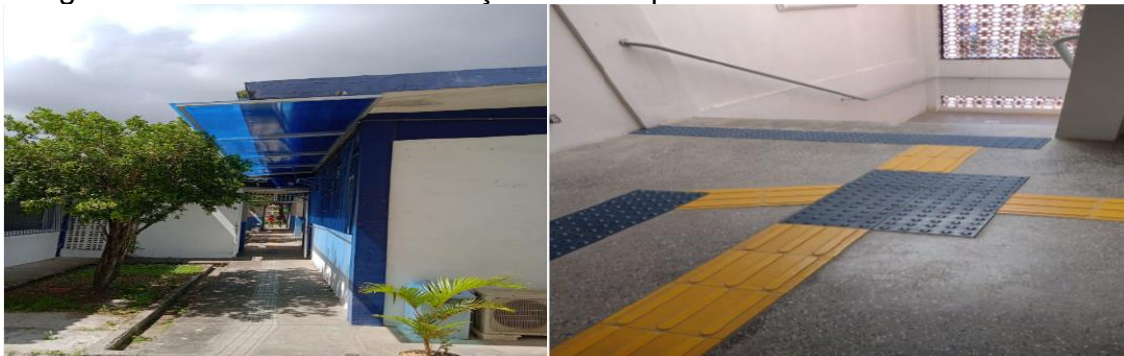
Figura 12 - Reforma e Manutenção no Campus V - Santo Antônio de Jesus
