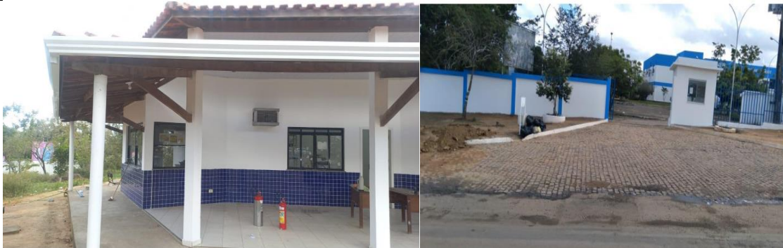
Figura 15 - Reforma do prédio principal, cantina e muro no Campus XIII – Itaberaba
