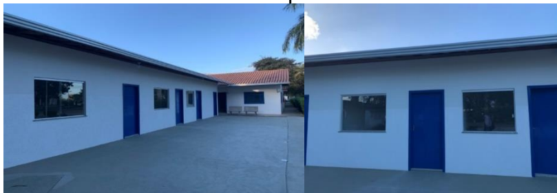
Figura 18 - Reforma de instalação e manutenção predial, a ser realizada no Departamento de Ciência Humanas e Tecnologias – DCHT no Campus XVIII – Eunápolis
