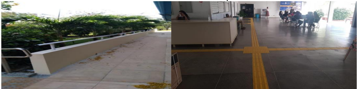
Figura 14 - Reforma para adaptação de acessibilidade do prédio de aulas administrativo - Fase 1 - Piso tátil no Campus XII – Guanambi
