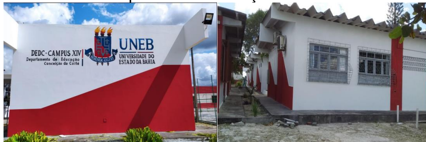
Figura 16 - Reforma e manutenção do Departamento de Educação (DEDC) no Campus XIV - Conceição de Coité
