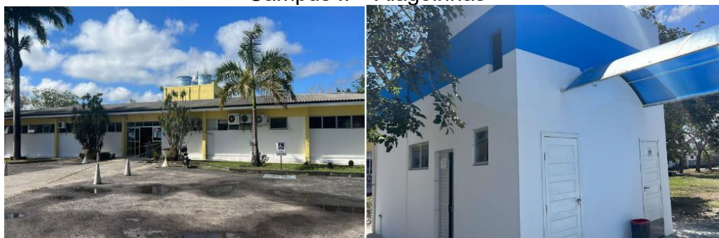
Figura 09 - Manutenção e reparo do prédio principal, prédio rosa e prédio azul do Campus II – Alagoas
