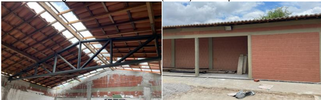
Figura 11 - Reforma da cobertura do prédio do Centro de Agroecologia, Energias Renováveis e Desenvolvimento Sustentável (CAERDES), do Departamento de Tecnologias e Ciências Sociais (DTCS) no Campus III - Juazeiro
